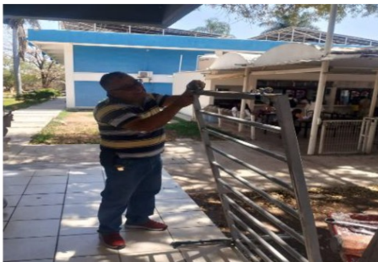
Foto 93. Reparación del cancel del Departamento de Psicopedagógico, marzo 2026.
