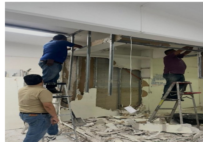
Foto 84. Retiro de pared de Tablaroca para ampliación de espacio para trabajo de estudiantes, octubre 2026.
