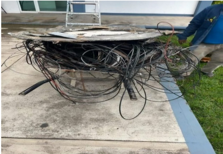
Foto 96. Retiro de cableado en desuso perteneciente al sistema videovigilancia, junio 2025.
