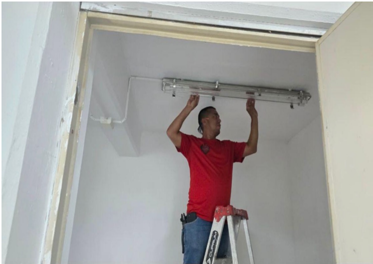
Foto 99. Cambio de luminarias de todas las áreas de la Unidad Académica de Medicina.
